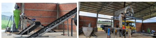
Hình 3. Nhà máy khi lắp đặt thiết bị thu bụi, sàng phân loại và đóng bao
