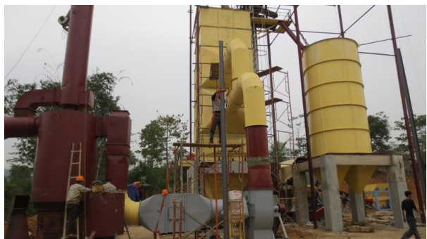
Hình 3. Lắp đặt các thiết bị lò đốt, silo và các thiết bị phụ trợ
