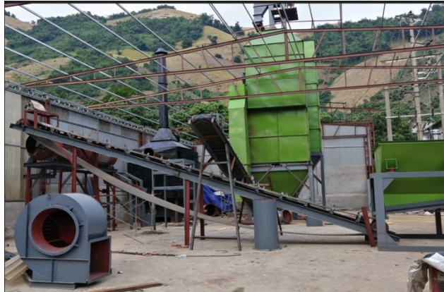
Hình 3. Lắp đặt phễu cấp, thiết bị tách cát và các thiết bị phụ trợ
