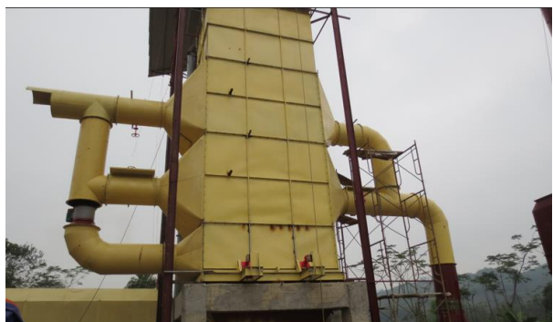
Hình 2. Lắp đặt hoàn thiện xong phần thiết bị sấy tháp
