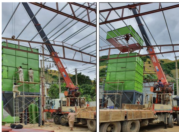
Hình 1. Cầu lắp đặt Hệ thống thiết bị sấy tháp tại cơ sở sản xuất
