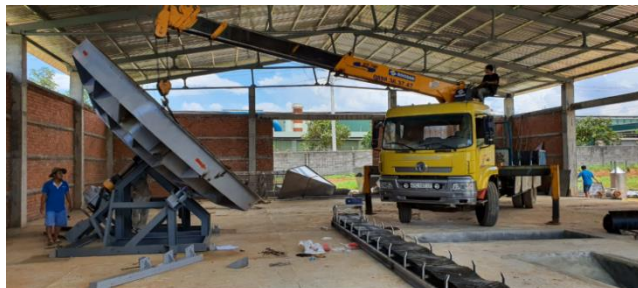
Hình 1. Nhà máy khi lắp đặt máy tạo viên
