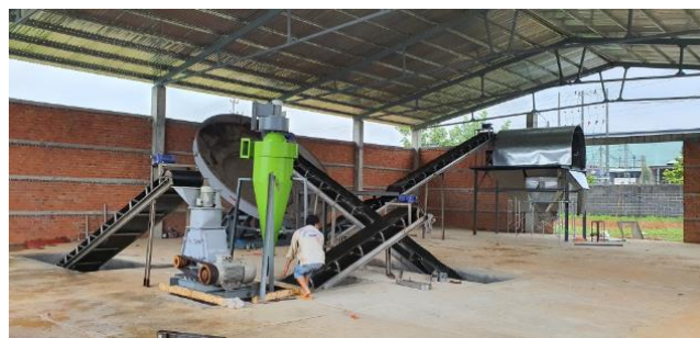
Hình 4. Nhà máy khi hoàn thiện công đoạn lắp đặt thiết bị
