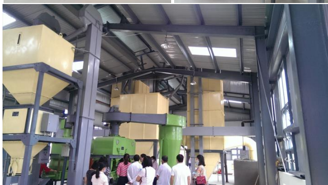
Hình 3. Hoàn thiện khâu lắp đặt, đào tạo hướng dẫn vận hành
