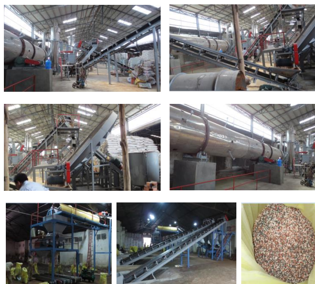
Hình 3. Lắp đặt và SX phân bón hữu cơ khoáng tại một số nhà máy
