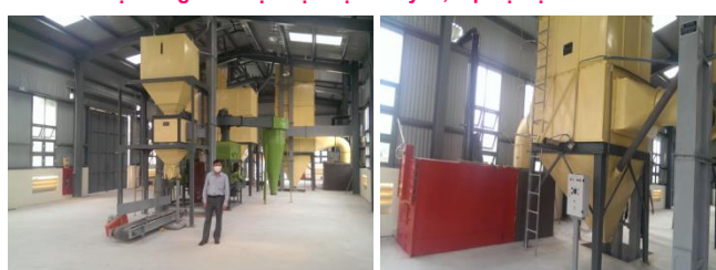
Hình 2. Hệ thống thiết bị được vận chuyển, lắp đặt tại cơ sở sản xuất
