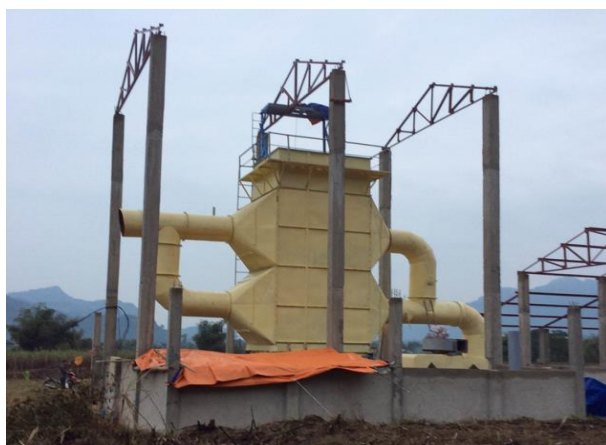
Hình 1. Cầu lắp đặt Hệ thống thiết bị sấy tháp tại nhà máy
