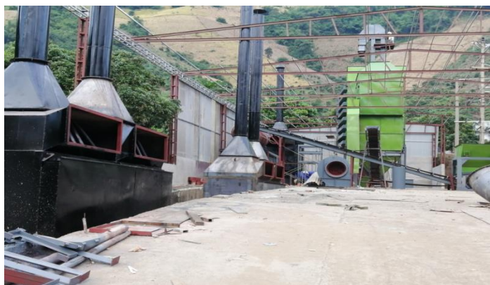
Hình 4. Hệ thống thiết bị được hoàn thiện lắp đặt trước khi đưa vào sử dụng chạy sản xuất
