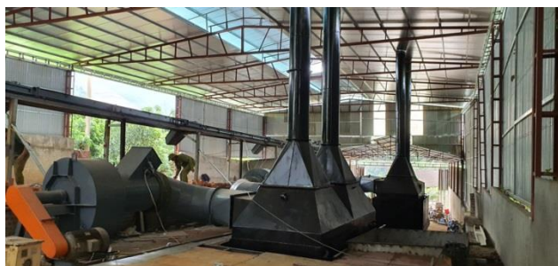
Hình 2. Lắp đặt Hệ thống thiết bị lò đốt sinh khối và hệ thống băng tải
